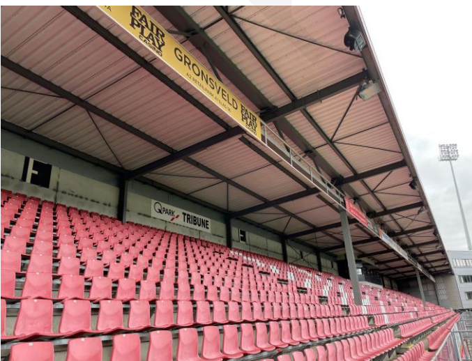
Overzicht tribune en onderzijde staalconstructie dak
