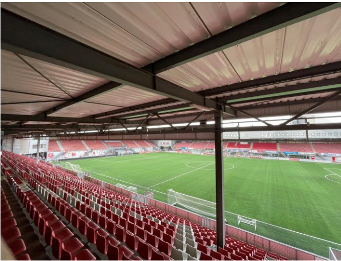
Overzicht staalconstructie dak
