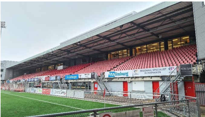
Overzicht totale tribuneconstructie inclusief onderzijde dak
