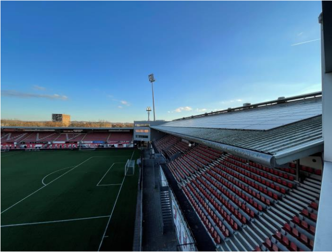
Overzicht tribune en bovenzijde dak
